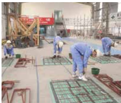
ベトナムでの鉄筋組立試験
