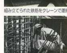
主筋に帯筋を巻いて柱を作る
