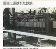
現場で鉄筋を組み立てる
