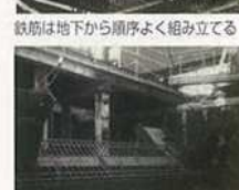
組み立てられた鉄筋をクレーンで運搬
