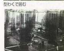
鉄筋は地下から順序よく組み立てる
